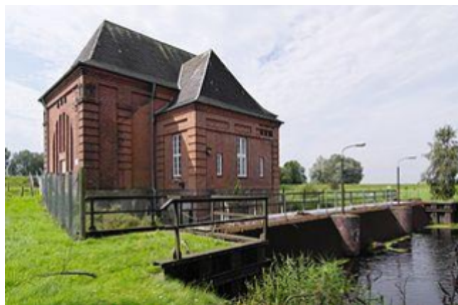
Steinschleuse ved Ejderen
